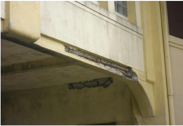
Bahnhof Varel: Diese beiden Bilder zeigen den „Prüfanriss“ bei der Personenüberführung, die aufgrund der anstehenden Elektrifizierung angehoben werden soll.
