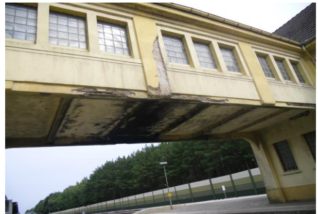
Bahnhof Varel: Diese beiden Bilder zeigen den „Prüfanriss“ bei der Personenüberführung, die aufgrund der anstehenden Elektrifizierung angehoben werden soll.
